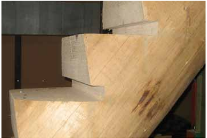
Für das Schneiden des Stammes, dem zentralen Teil einer Baumstamm-treppe, wurde ein spezieller Sägekopf entwickelt.
